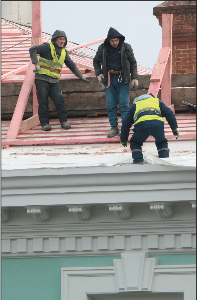
«Циркачам» страховка не требуется. Ремонт кровли на одном из зданий УМВД по адресу: Тула, пр. Ленина, 53. Рядом – здание областной прокуратуры. Фото сделано из окна ТФП 24 января во время подготовки материала к публикации.
